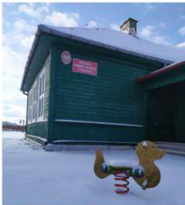
Budynek szkolny w Wieprzowie
